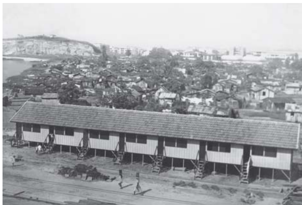
Início da construção do Parque Proletário Provisório nº 3 – Praia do Pinto – RJ - Código - VT/ MS/19390207
