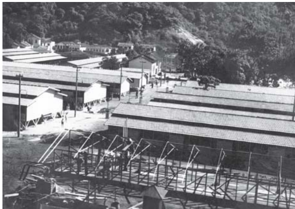
Construção do Parque Proletário Provisório nº 1 – Gávea – RJ - Código - VT/MS/ 19390207
