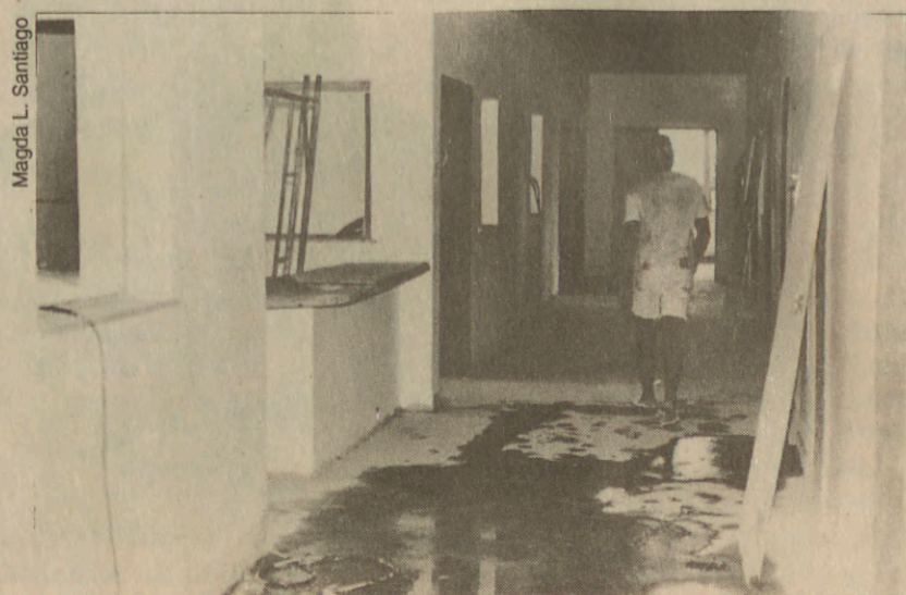
Reforma e ampliação no Hospital Odilon Behrens: atendimento ampliado
