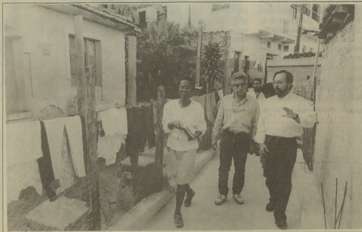
Obra na Vila Dias, em Santa Tereza: urbanização, com drenagem e pavimentação garantidos através do OP
