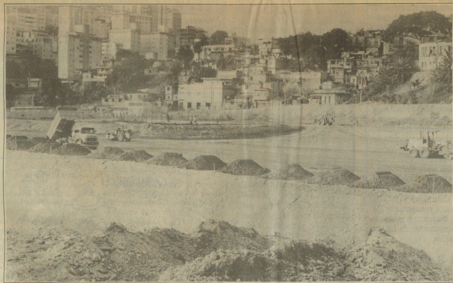
Obras na Barragem Santa Lúcia: Prefeitura vai transformar a área num imenso parque, com praças e campos
