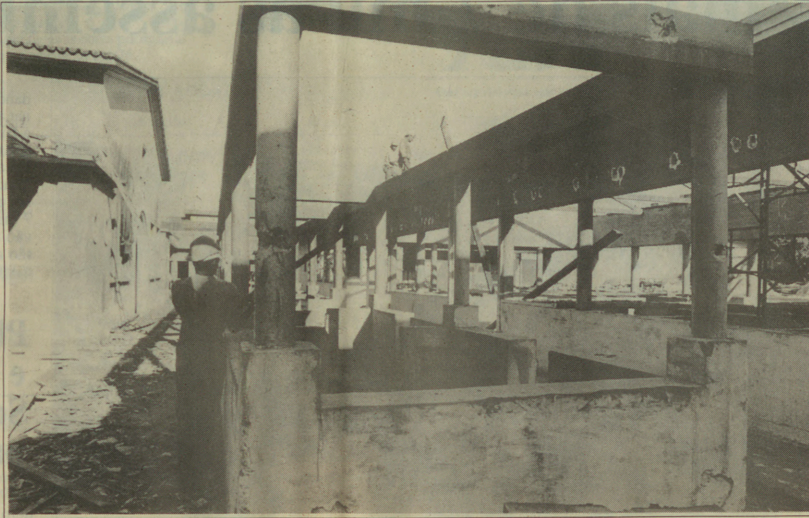
A recuperação do Mercado da Lagoinha: executada pela Prefeitura, obra vai garantir nova opção de abastecimento e atividades culturais
