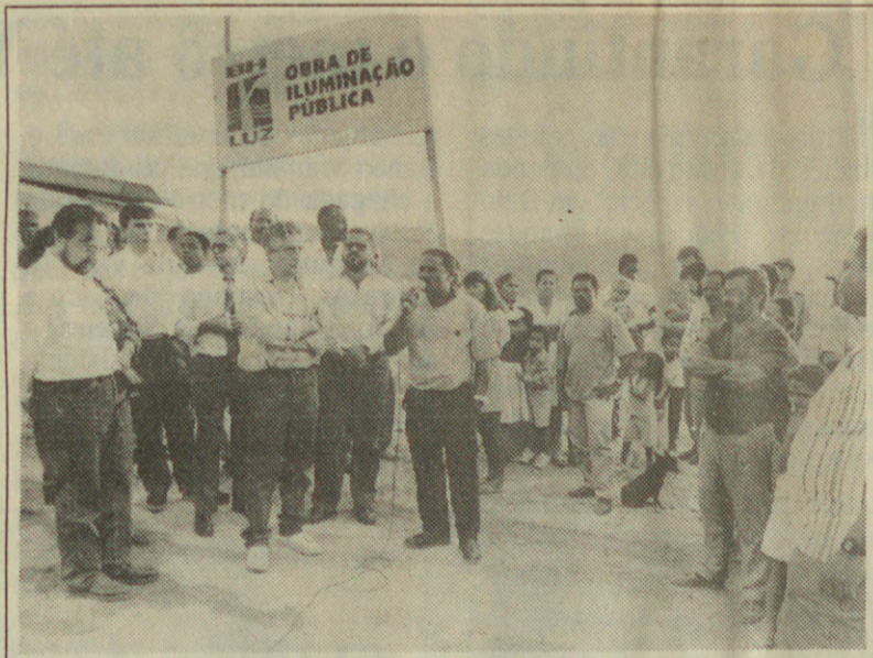
Vila Fazendinha no Aglomerado da Serra: em urbanização
