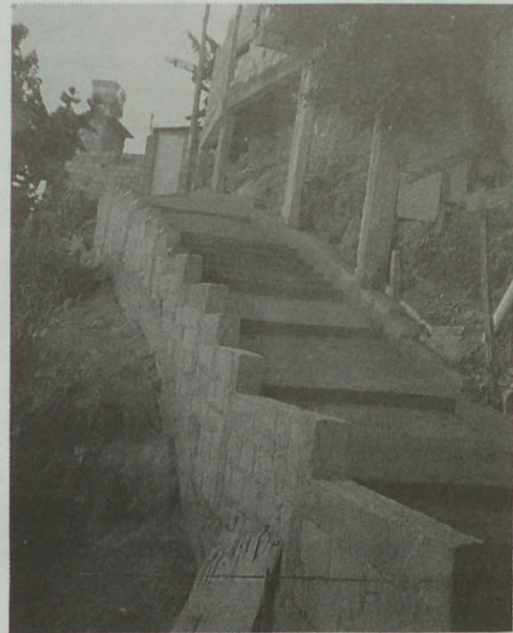
Melhoria de via de acesso, drenagem e contenção, na Vila Papagaio
