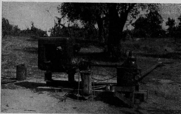
Conjunto motor e bomba, para aspirar a água de um poço artesiano e impulsioná-la para o depósito. Apontado pela seta, vê-se o aparelho de cloração.
